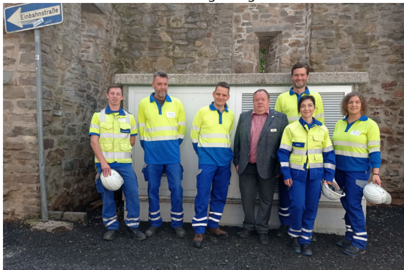
Marco Van Assche (v.l.), Ottmar Kirschstein, Leonhard Birnbaum, Kurt Reidenbach, Patrick Wittenberg, Katerina Reiche und Carina Schneider vor der neuen Trafostation in der Turmstraße. Foto: J. Mager/Stadt Bad Münstereifel
