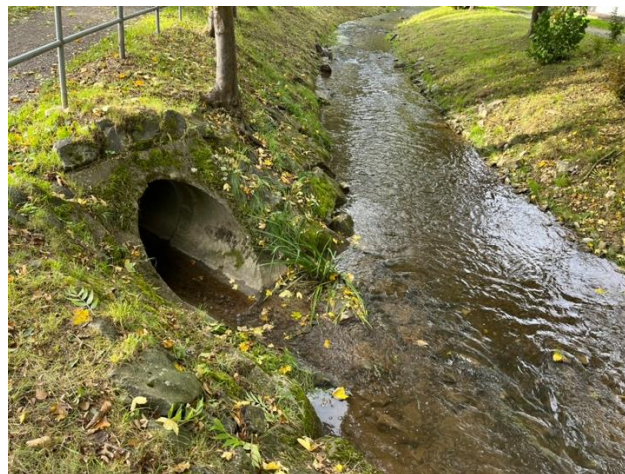
Abbildung 13: Mündungsbereich des Holzbachs im IST-Zustand.
