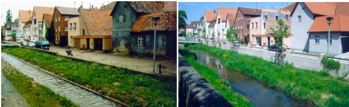
Abbildung 15: Beispielhafte Umsetzung anhand der Umgestaltung des Schwabachs in Schwabach. Sohl- und Uferverbau wurden entfernt, das Niedrigwasserprofil jedoch nahezu beibehalten. Dagegen wurde das Hochwasserprofil zugunsten eines Kastenprofils aufgeweitet und durch Hochwasserschutzmauern erhöht. (Bildquelle: (DWA, 2018))
