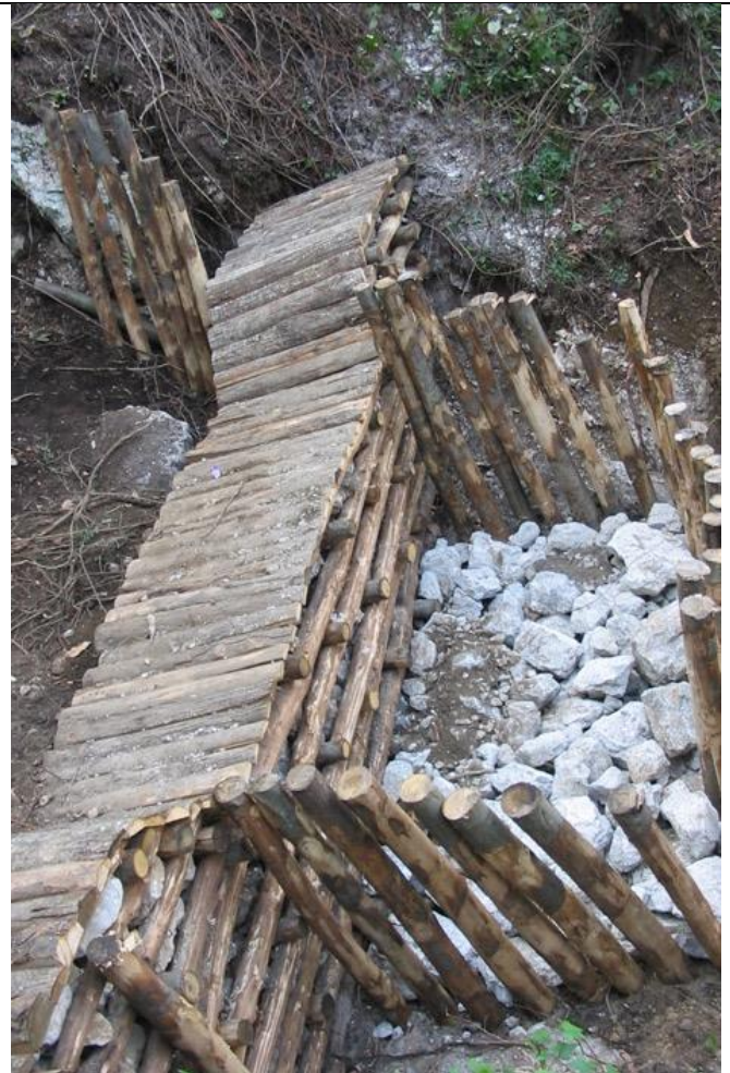
Abbildung 39: Beispiel einer schanzenartig quer zur Fließrichtung eingebrachten Krainerwand. Sofortige Stabilisierung, die von oben und seitlich belastbar ist (Wegebau). Das Holzgerüst armiert Böschung und Grabensohle. Nach dem Anwachsen erfolgt bei Durchströmung des Austriebs die Energiedissipation. Die Wurzeln übernehmen zunehmend die stabilisierende Funktion des Holzes. Bau auch auf wenig belastbarem Untergrund möglich, da die Holzkonstruktion leichter als Steinverbauungen ist.
