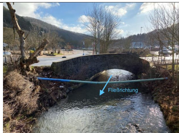
Abbildung 25: Foto des Brückenbauwerks BW30 Sittardweg.
