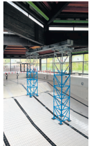
Mit Hilfe der Gerüstkonstruktion wird das Dach gestützt und die Öffnung des eifelbades ermöglicht. Foto: Stadt Bad Münstereifel
